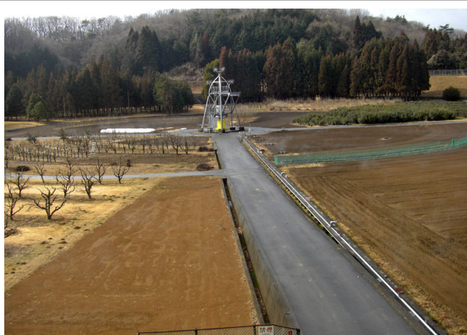
ガンマフィールド・写真中央の塔からガンマ線・エックス線を周囲の農作物に照射
